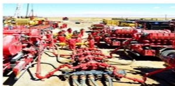
油田压裂系统装置
