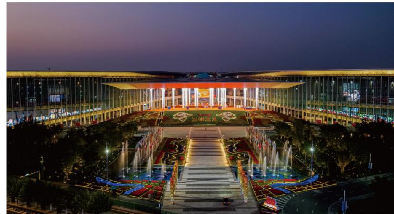
中国国际进口博览会场馆—国际会展中心（上海）改建
