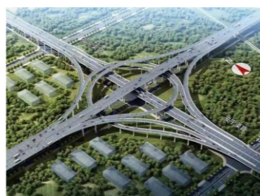
东进场高架道路
