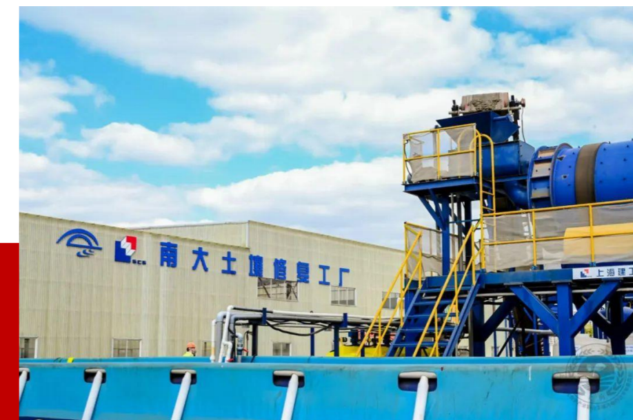
上海建工宝山南大土壤修复工厂
