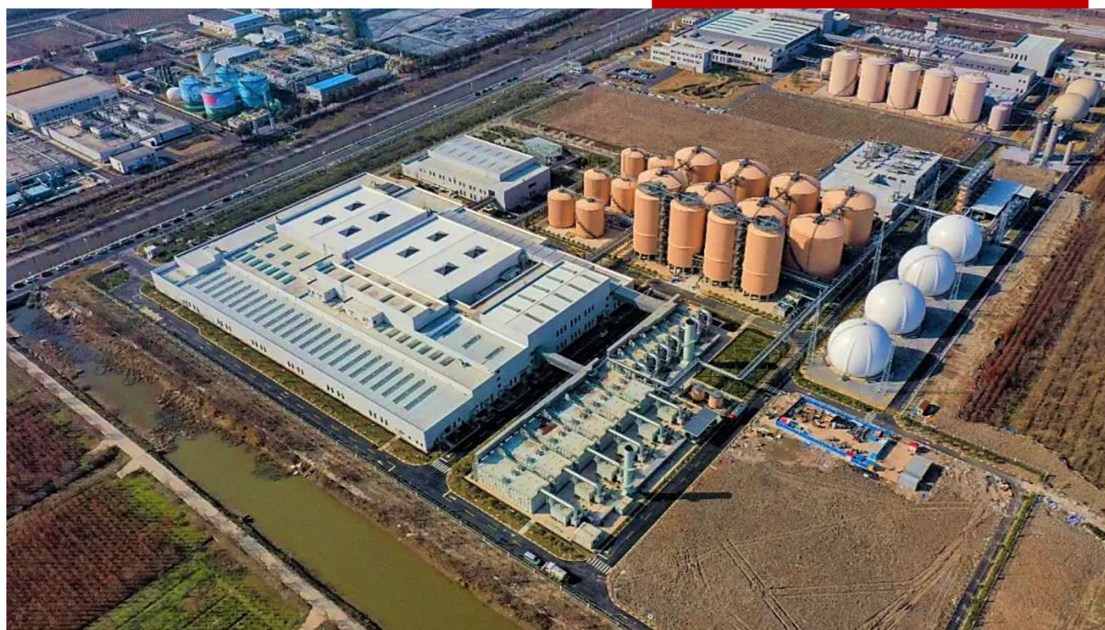
上海生物能源再利用项目（二期）
