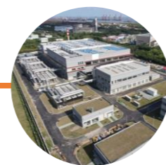
石洞口污水处理厂二期
