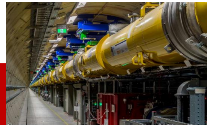
硬X射线超导低温模组安装
