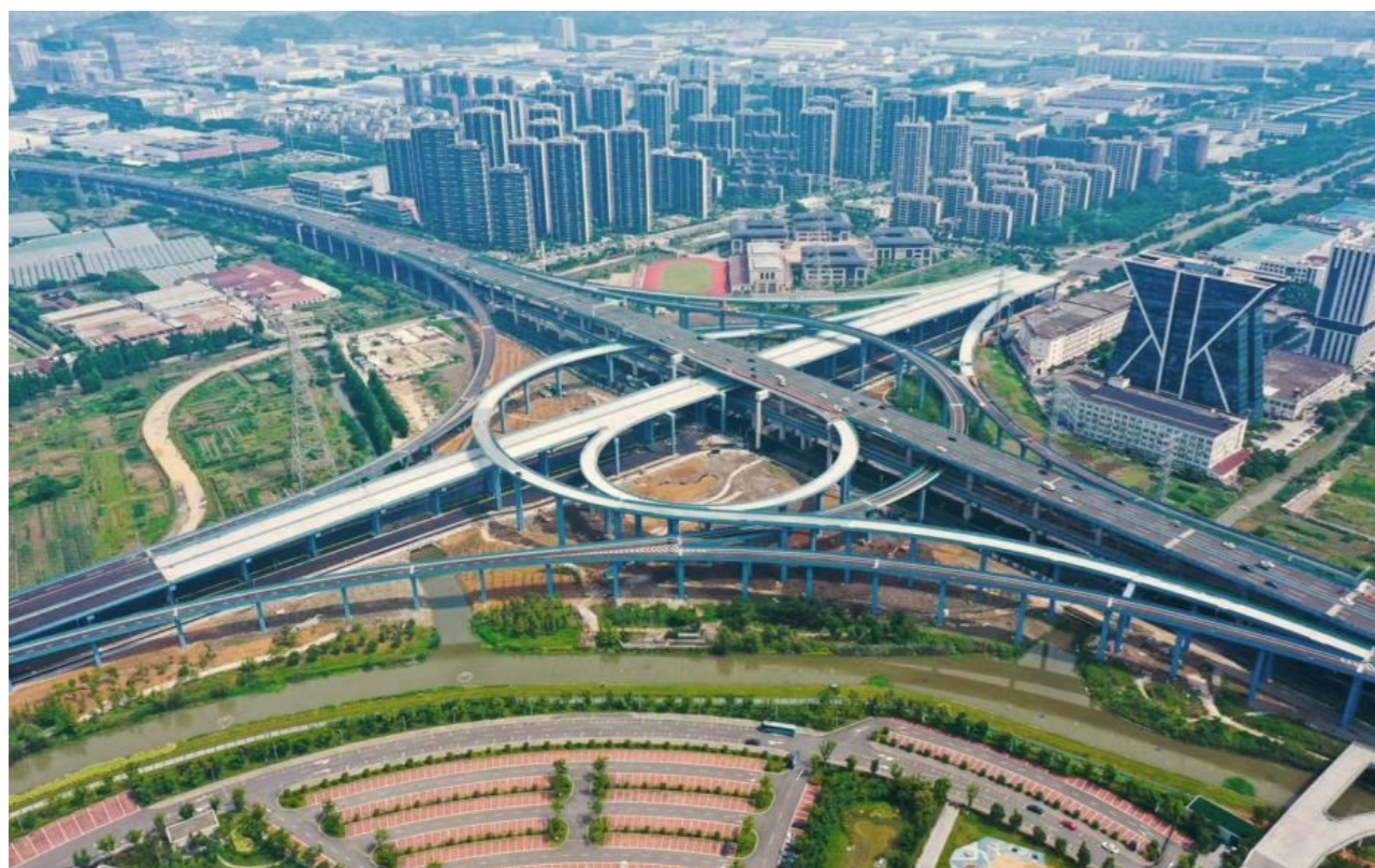
宁波西洪大桥及主线高架
