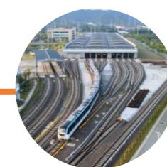
无锡地铁3号线一期工程
