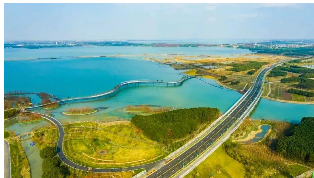
淀山湖、元荡岸线综合治理 长三角示范区重点工程
