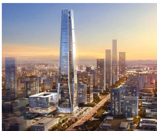
图7：NCC钢结构应用于超高层建筑
