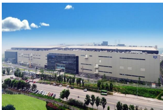
图6：NCC钢结构应用于高端电子厂房
