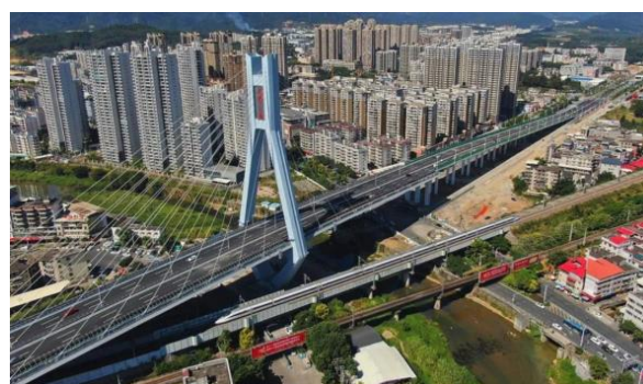
图10：NCC钢结构应用于公路跨线桥
