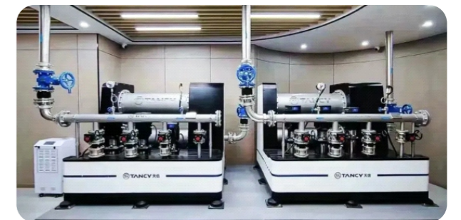
金卡水务助力苍南二次供水设施改造，让高层用水不再难
