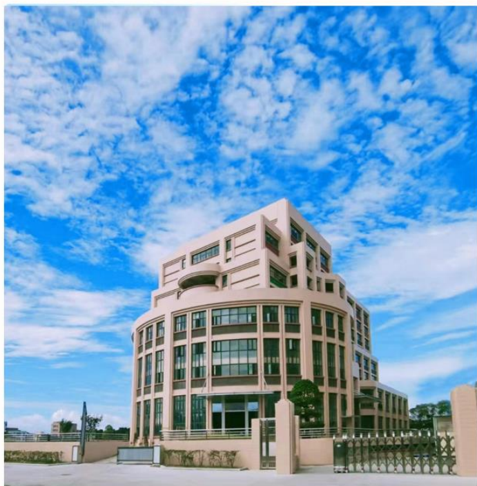
上图：妇产医院综合大楼
