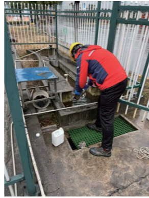
工人正在监测雨水排放口
