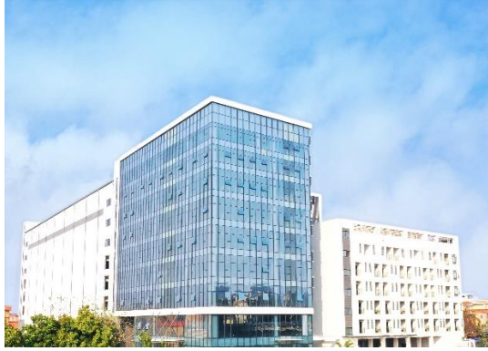
图：公司新建 LED 智能照明生产基地
