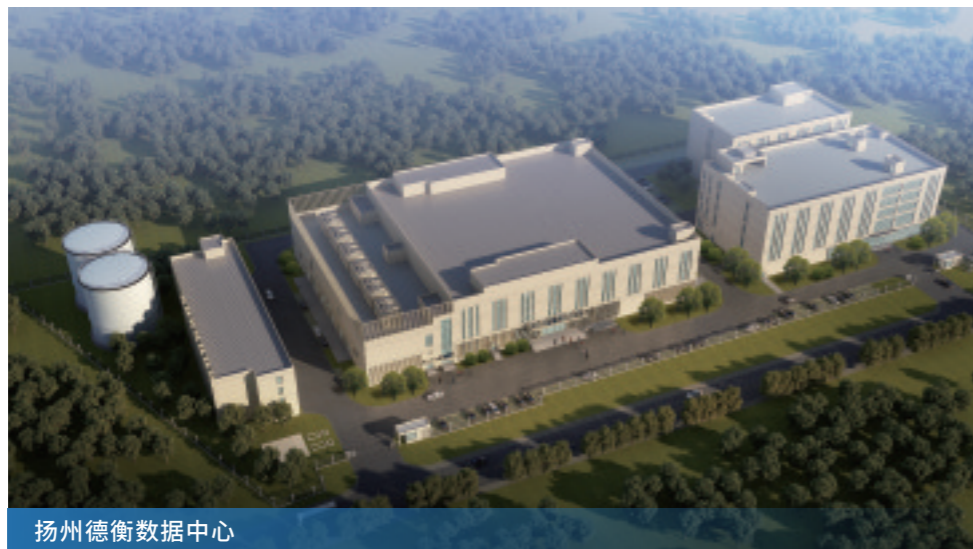
扬州德衡数据中心
