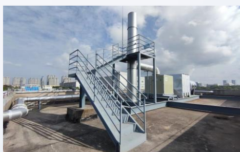
污水站废气净化系统升级改造项目
