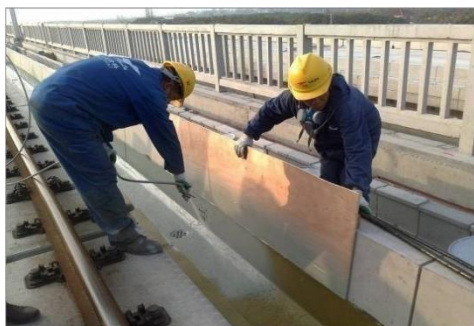
轨道建设防水
