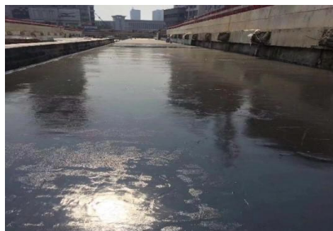
城市轨道交通工程防水
