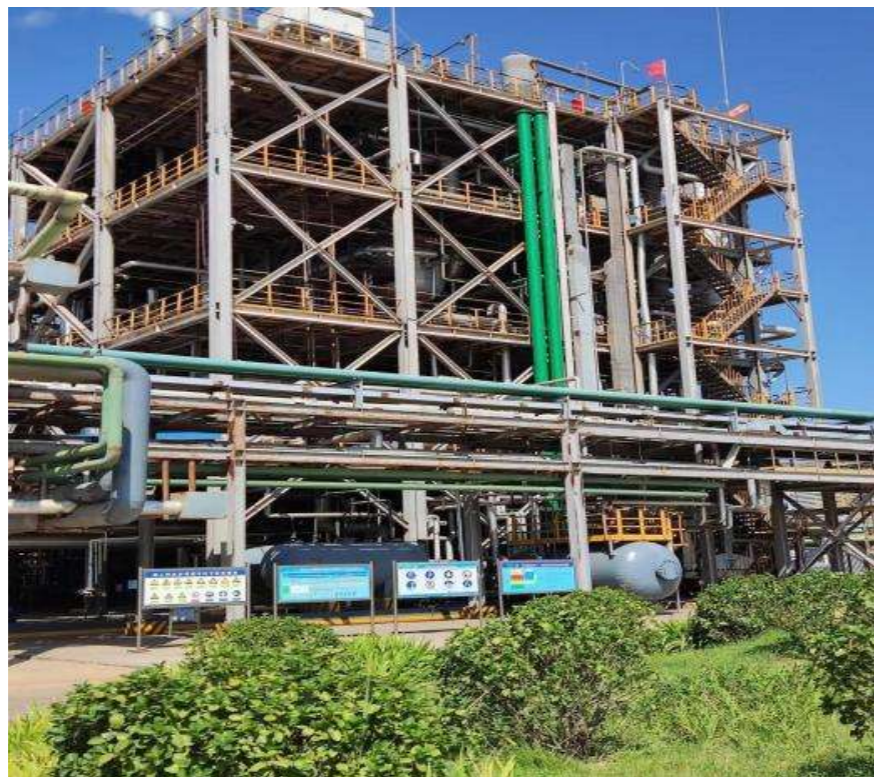
▲ TDI工艺废渣利用项目
