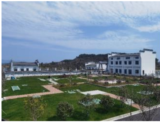
九江市武宁县生活污水处理项目（2万吨/日）
