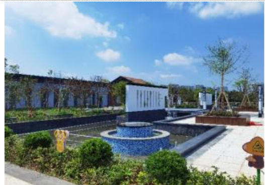
南昌市新建城地下生态水厂（2 万吨/日）
