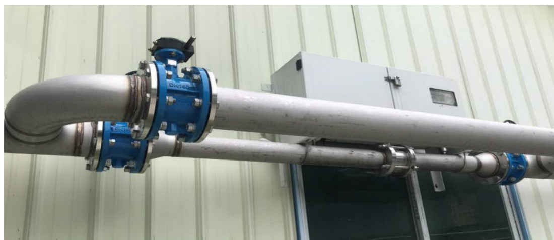
“空压机供气管道更换”方案
