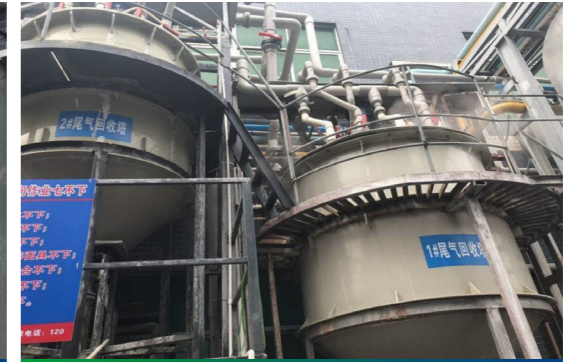
方案实施后使用的氨气吸收装置
