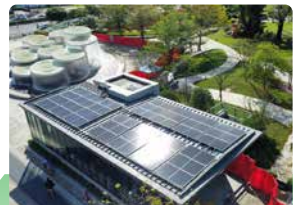
地铁莲花站分布式光伏项目
