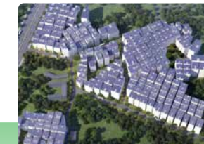
福田区石厦光伏新村分布式光伏项目
