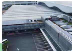
深圳北站综合交通枢纽分布式光伏绿色能源项目
