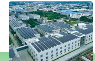
江西曼妮芬工业园区分布式光伏电站一期
