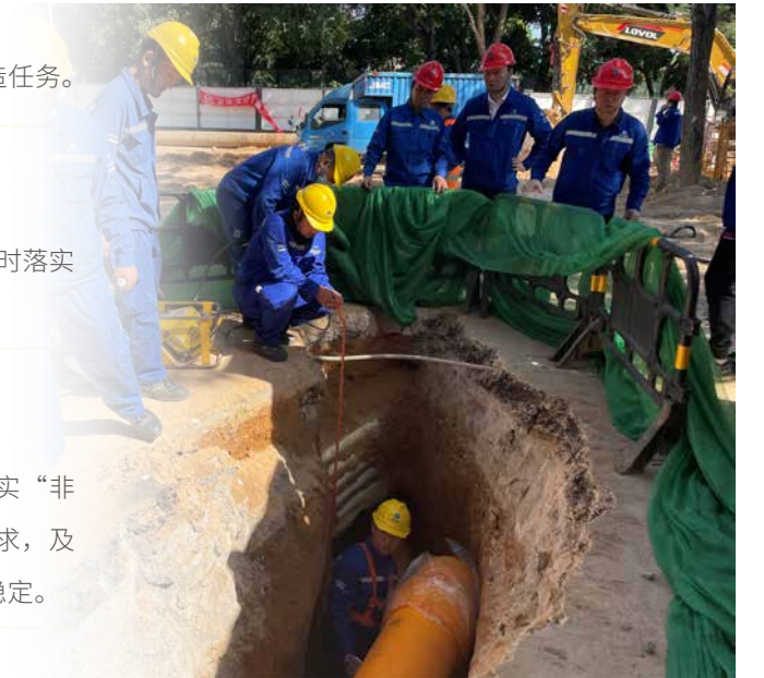
老旧中压钢质燃气管道更新改造工程现场
