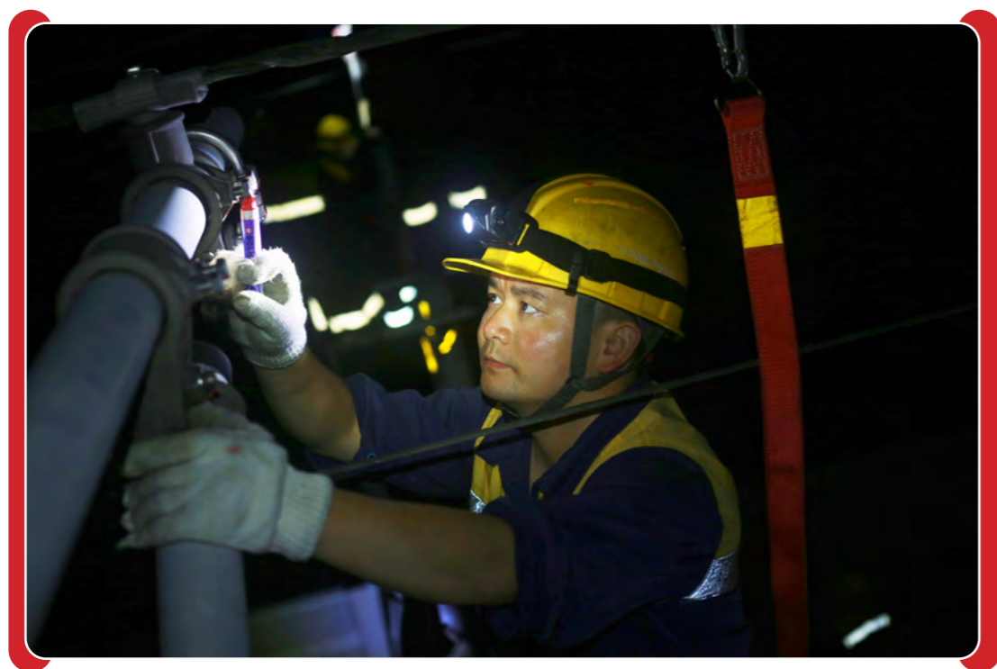
供电接触网设备检修
