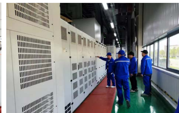
日常隐患排查
