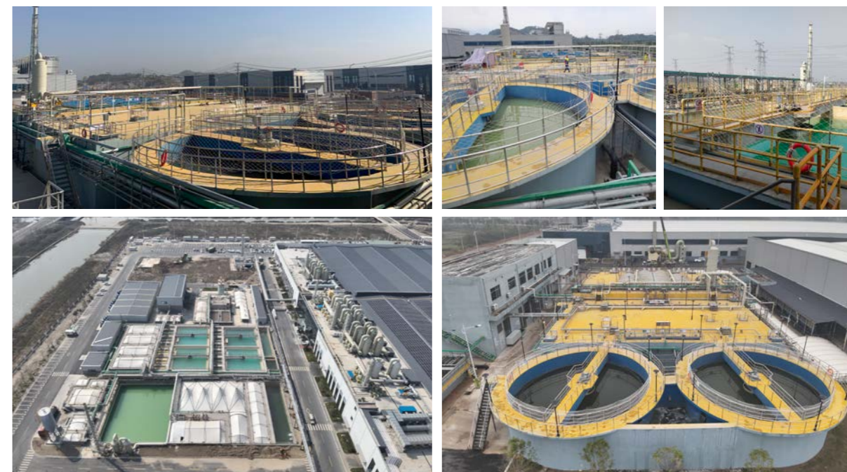
废水治理设施
