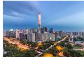
项目名称： 深圳平安金融中心 选用科顺股份材料： 蠕变型橡胶沥青防水涂料 高聚物改性沥青耐根穿刺防水卷材
