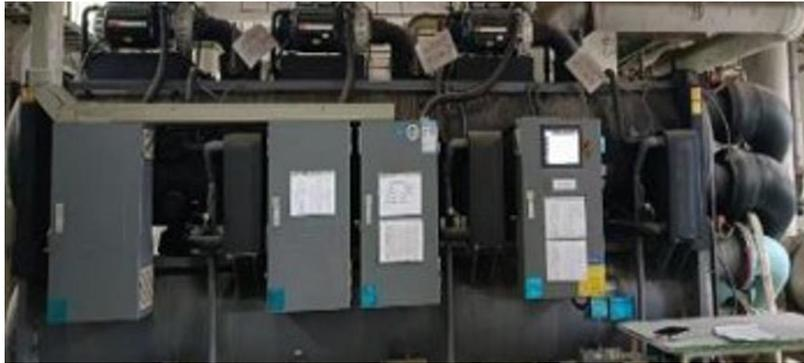
龙华 / 杭州园区，通过汰换磁悬浮 / 直流变频冰水主机，全年平均节能率超过 30%
