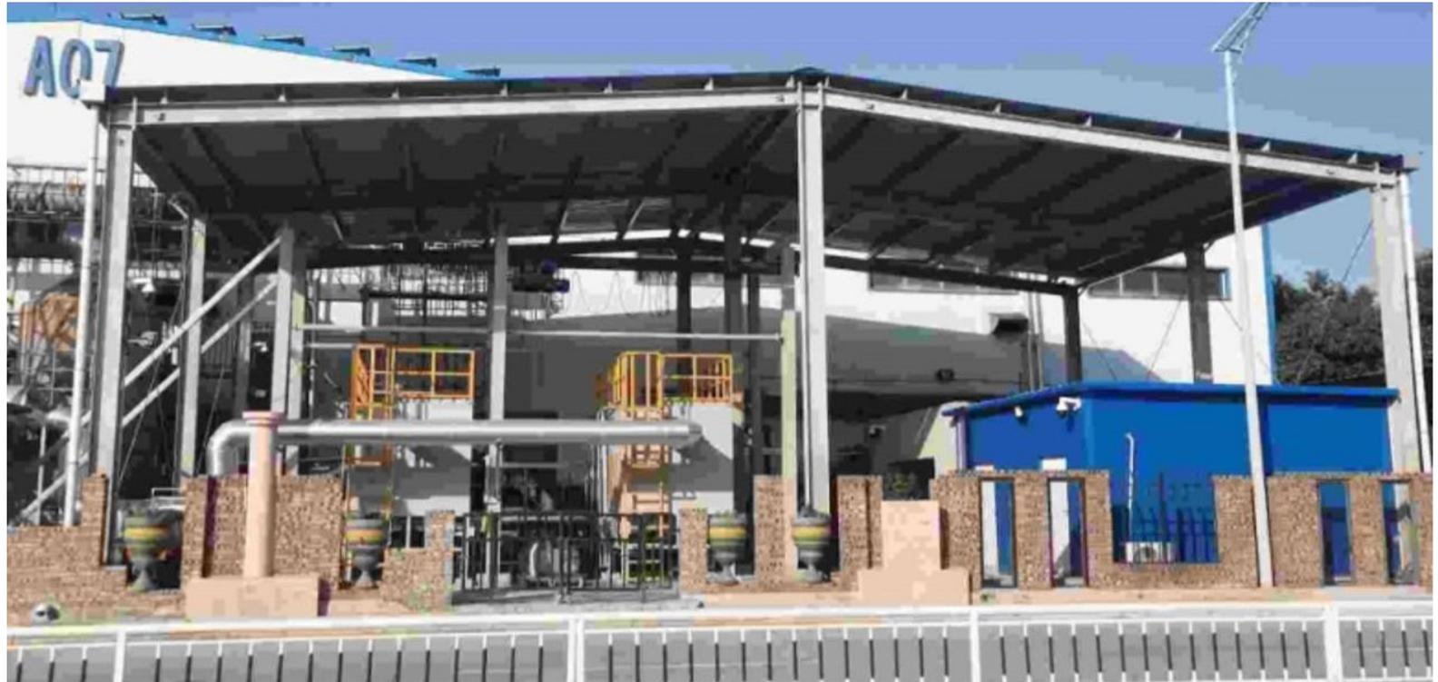
我们为降低废气处理设施运行成本，投资 150 万元在济源园区建成废活性炭再生中心，利用“热脱附 + 尾气燃烧余热回用”工艺对自产废活性炭进行再生利用，活性炭再生处置能力约 600 吨 / 年 (t/a)，试运营期间（2022 年 9 月 -2023 年 1 月），共处置、利用废活性炭 41.12 吨 (t)，预估每年可节约费用 132.662 万元。
