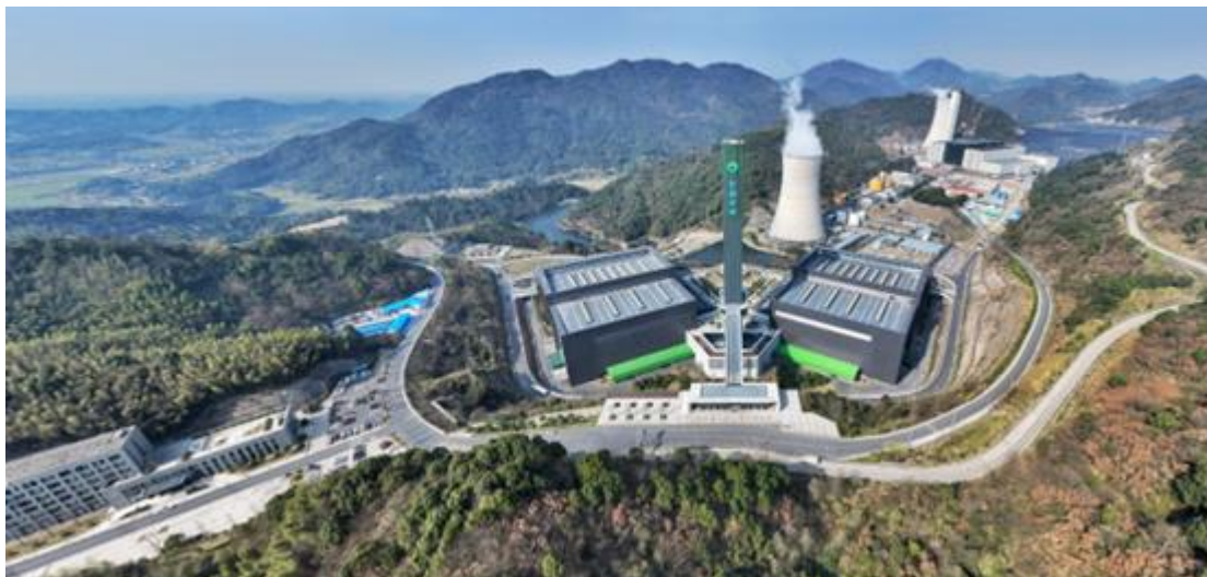
图 1 公司经营的长沙市城市固体废弃物处理场
