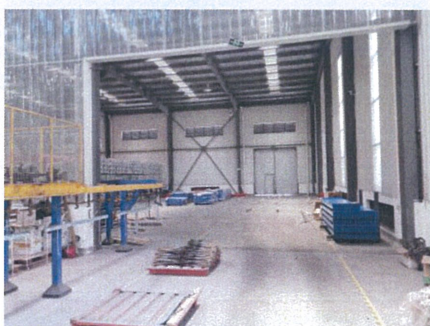
估价对象1 室内状况
