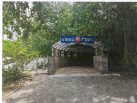
地下车库出口
