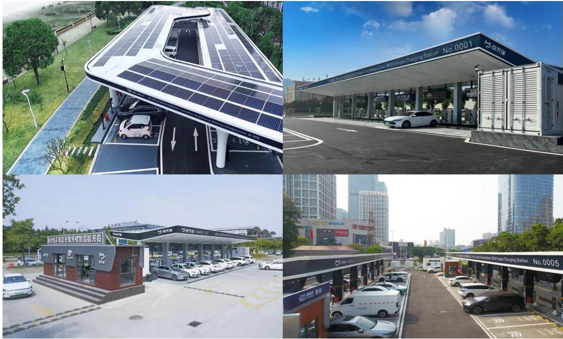
注：图为福州、宁德已投入使用的数个光储充检一体化智能电站。
