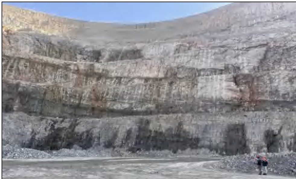
图 1-6 B 区边坡现状图
