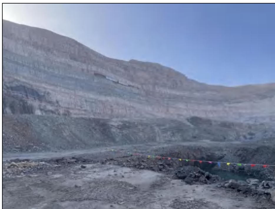
图 1-7 C 区边坡现状图
