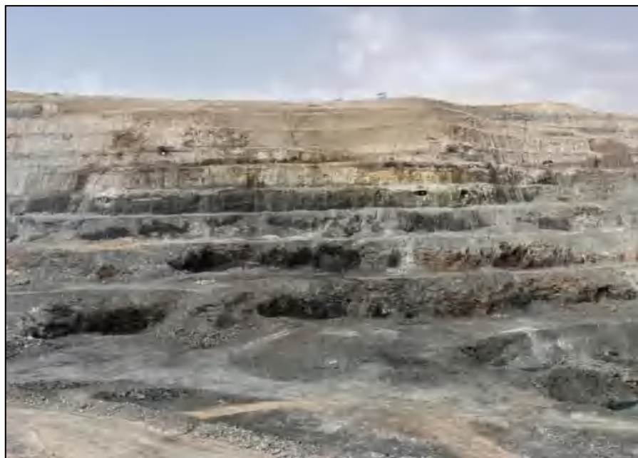
图 1-8 D-1 区边坡现状图
