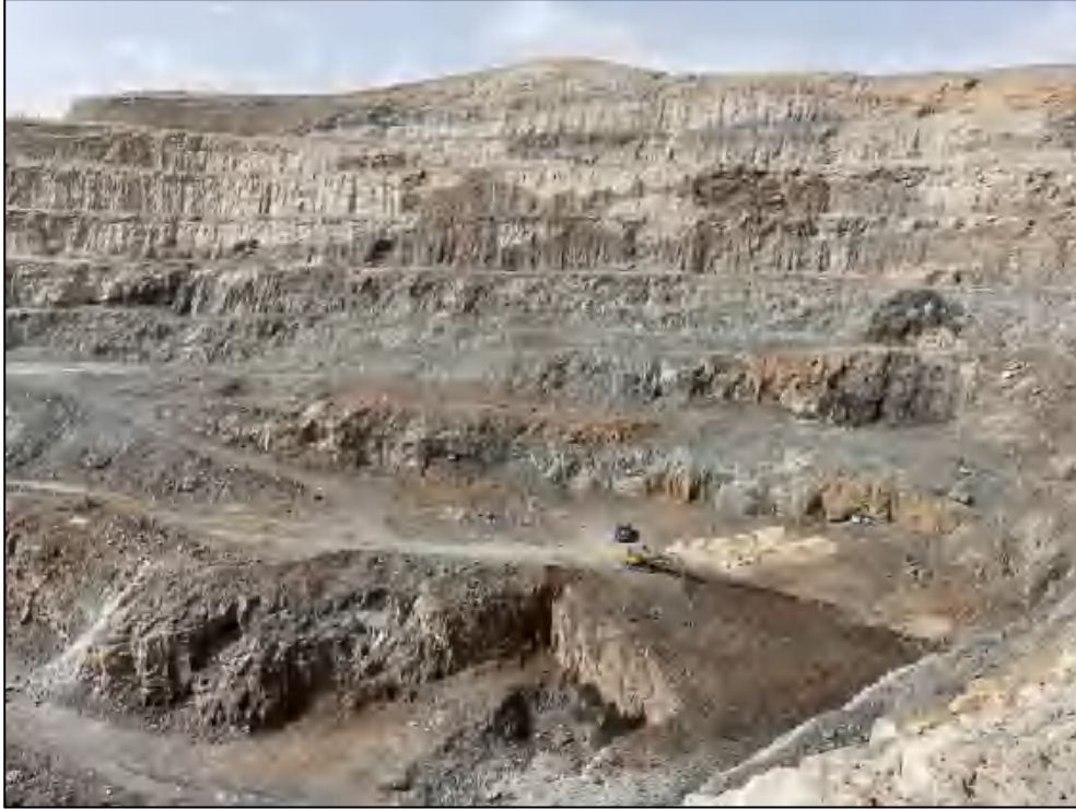
图 1-10 E 区边坡现状图
