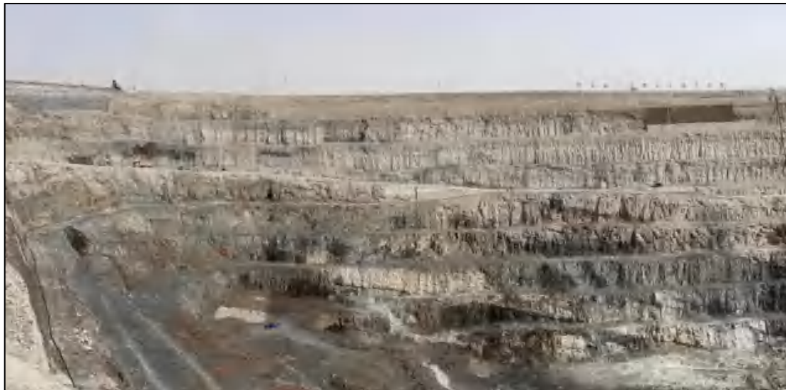
图 1-5 A 区边坡现状图
