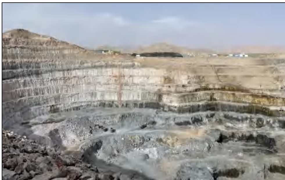
图 1-9 D-2 区边坡现状图
