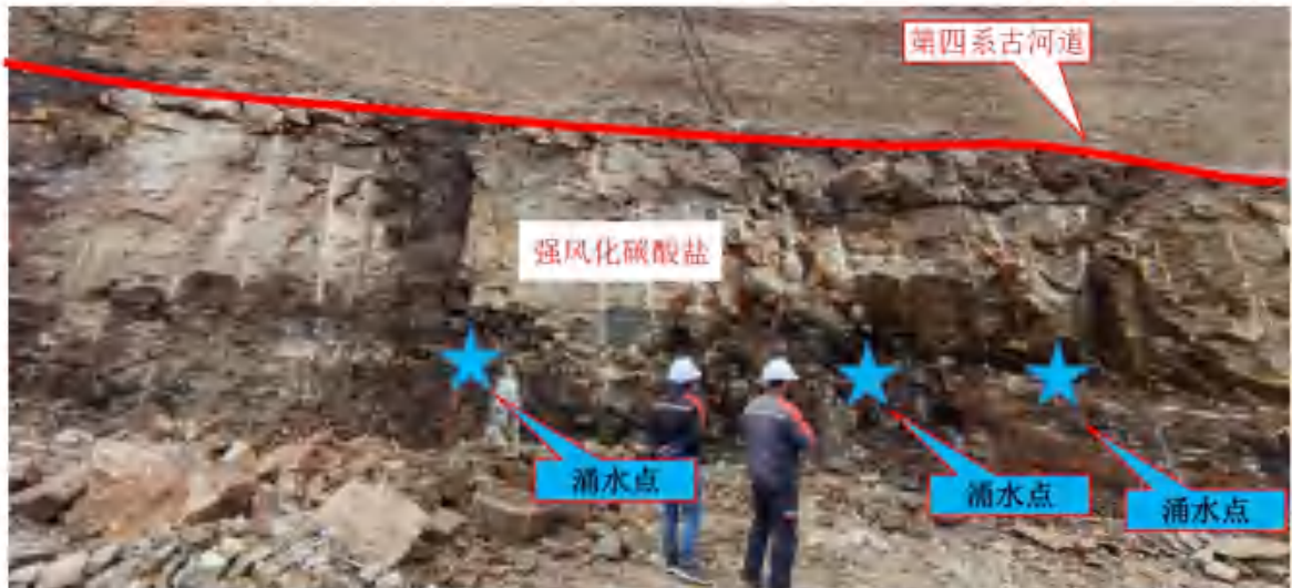
图 1-12 南侧（古河道上游）第四系及下伏破碎带涌水
