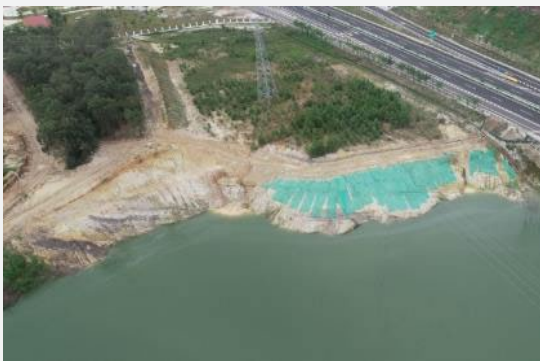
矿湖边坡修复治理前后对比图
