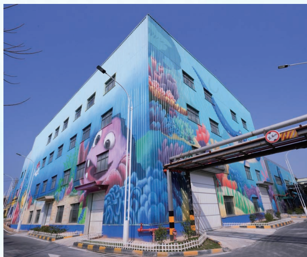
环境公司南宁蓝德有机垃圾处理项目
