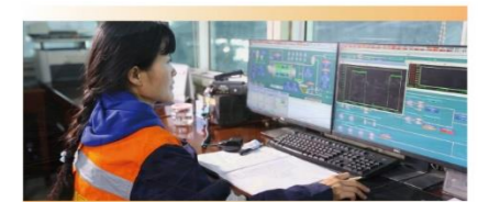
▲ 青海大柴旦智能矿山监控系统
