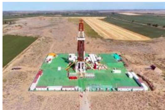
▲施工场所铺设防尘网
