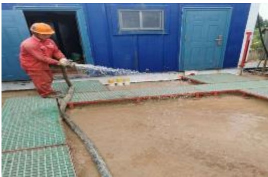
▲井场洒水降尘
