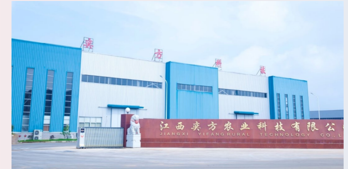
江西奕方厂区
