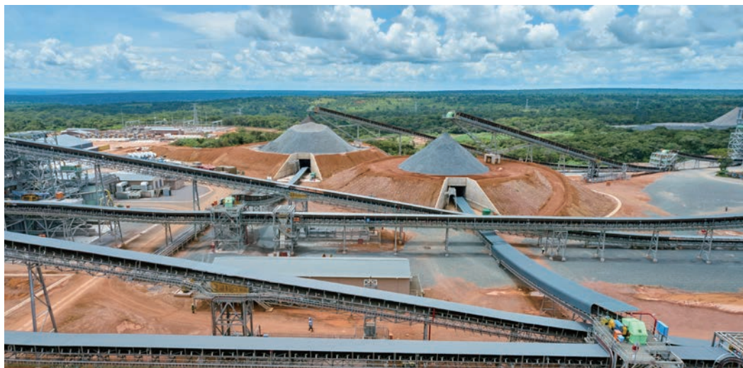
艾芬豪矿业 KK 铜矿项目二期顺利投产
