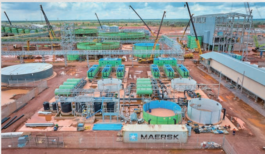
卡莫阿 III 期选厂 - 砂滤机最新建设进度
