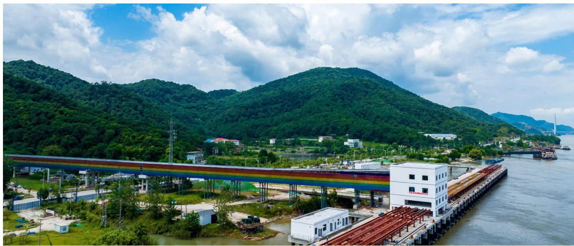
瑞昌骨料廊道光伏发电项目
