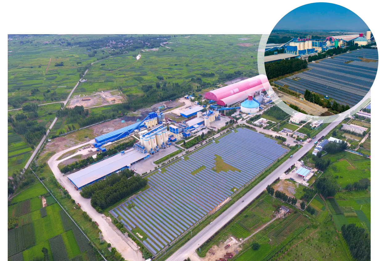
临沂中联光伏发电项目
