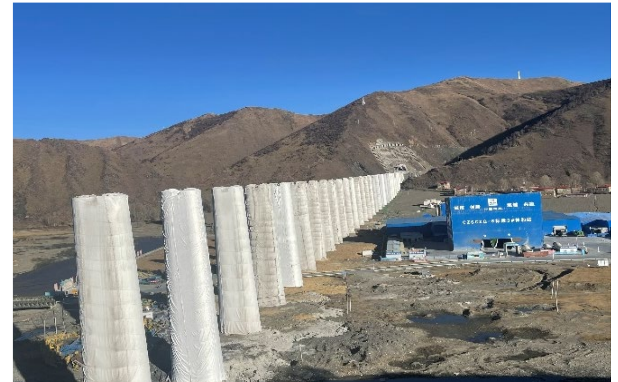
川藏铁路工程现场
