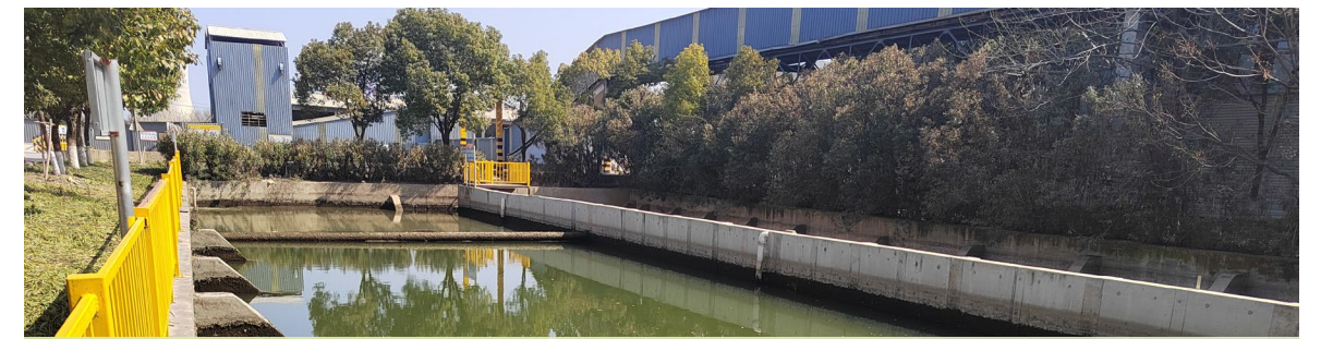
江苏新街南方水泥有限公司厂区总回水池
