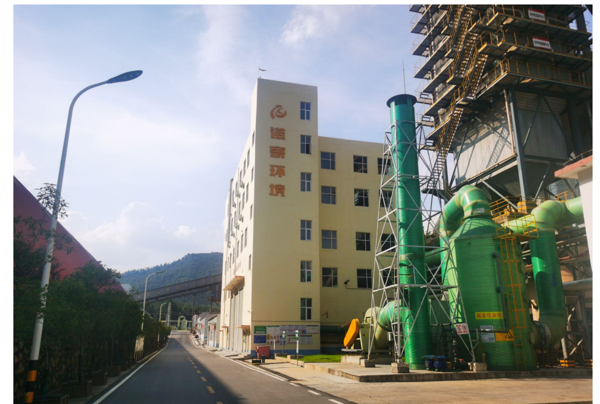
南城南方水泥窑协同处置固体废物项目
