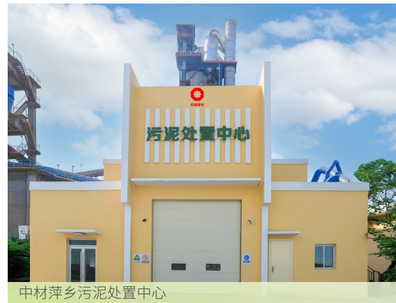
中材萍乡污泥处置中心
