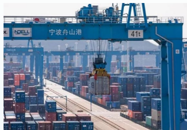
完成 16 台轨道吊自动化改造项目，实现现有 52 台轨道吊全部自动化
