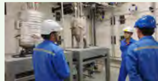
台山核电总经理刘丹开展现场安全检查
