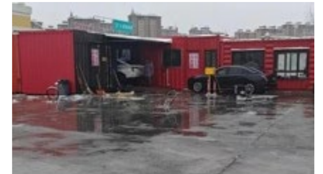
“旗E春城”四期换电站
