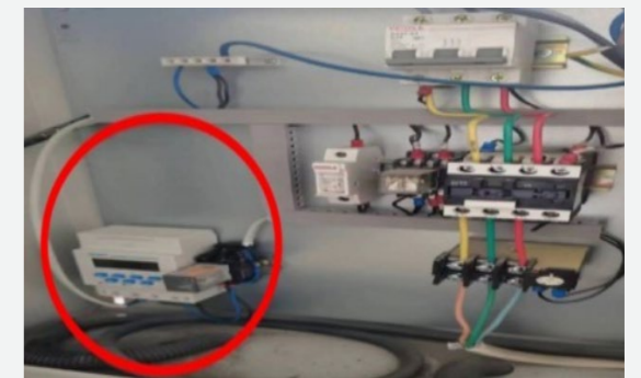
车间门体电路改造
