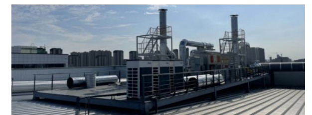
废气治理实施催化燃烧改造设备
