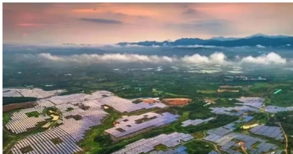
▲ 本行广东分行支持建设某农业光伏综合开发项目。
