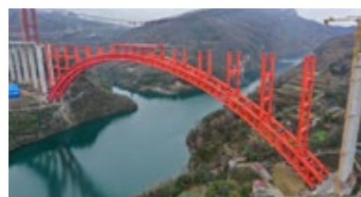
▲ 本行贵州分行贷款支持的乌江特大桥。
