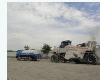
旧路材料再生利用
