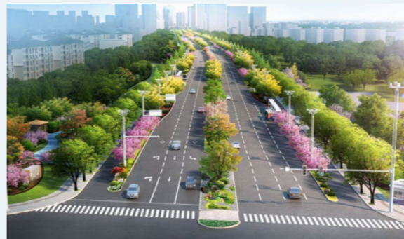
华西路 (G2 高速至楚州大道) 改造及景观提升工程
