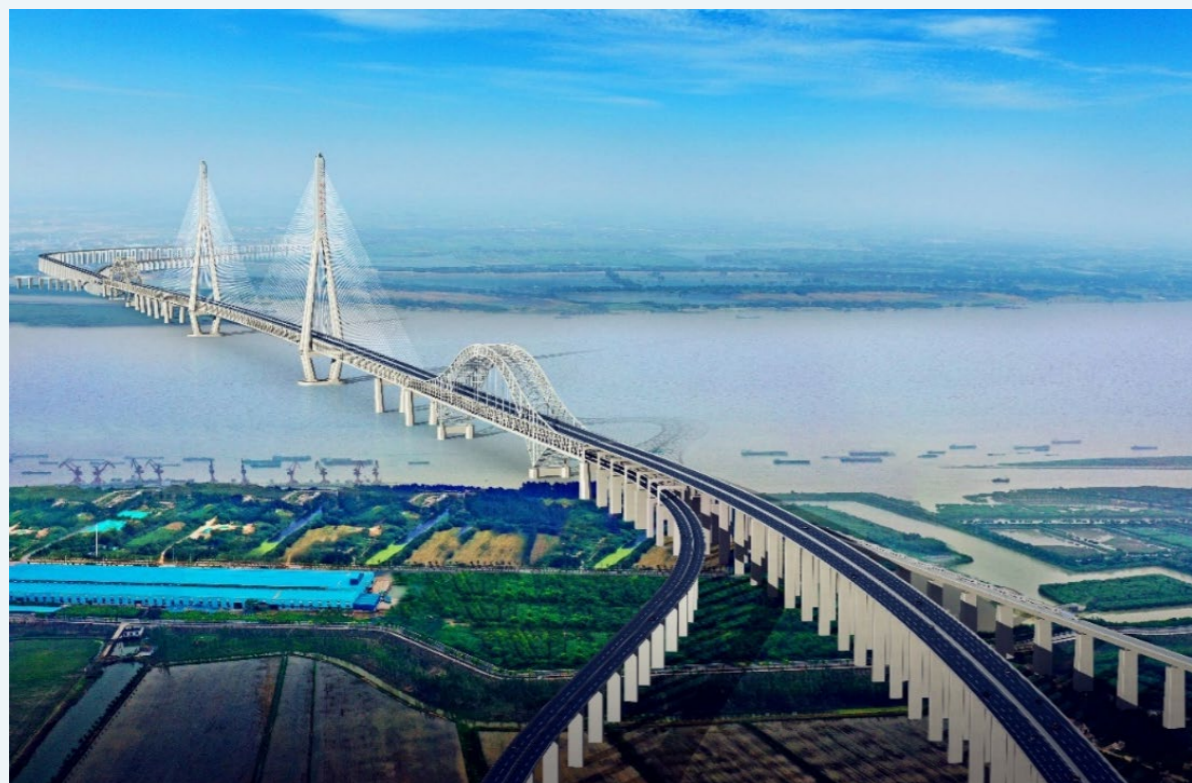
常泰长江大桥“未来智慧大桥”
