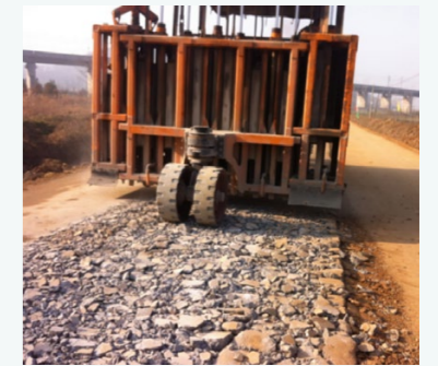
水泥路面碎石化
