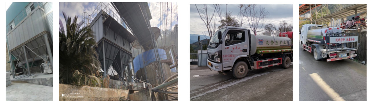
车间内安装的除尘器减少粉尘
