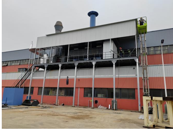
“干式过滤+活性炭吸附脱附+催化燃烧”废气处理系统
