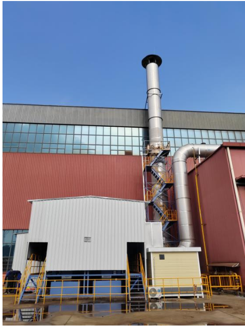
“干式过滤+活性炭吸附脱附+催化燃烧”废气处理系统
