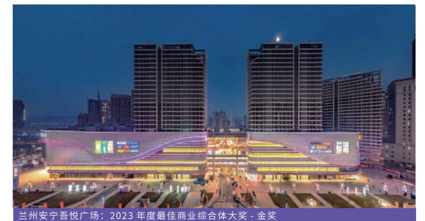
兰州安宁吾悦广场：2023 年度最佳商业综合体大奖 - 金奖
