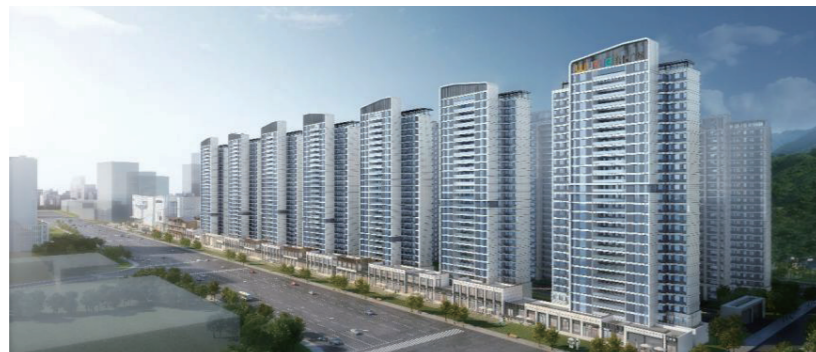
山东省装配式示范工程项目—烟台芝罘吾悦首府项目
