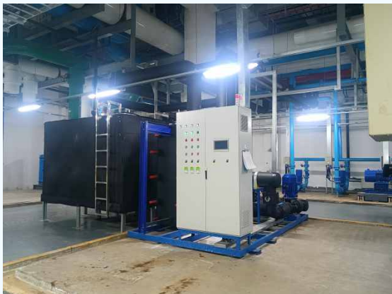
空压机冷却系统改进
