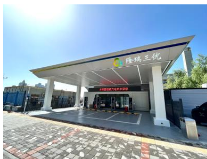
图注：木樨园超级充电站
