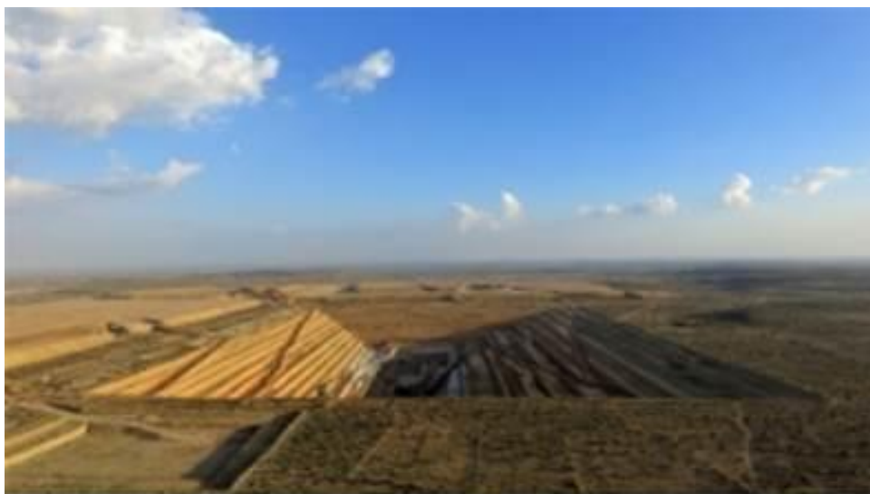
图五 巴基斯坦塔尔煤田 II 区块项目
