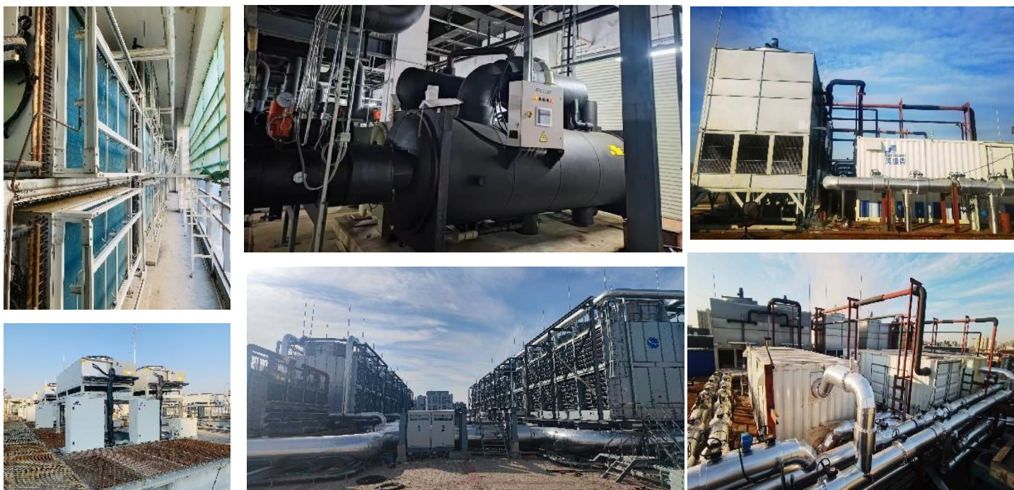
中金云网数据中心 风冷氟泵空调改造
