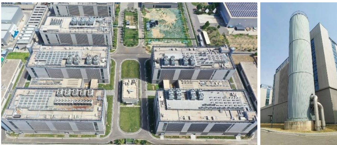
北京房山数据中心屋顶冷却塔及储冷
