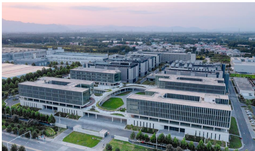
公司北京房山数据中心
