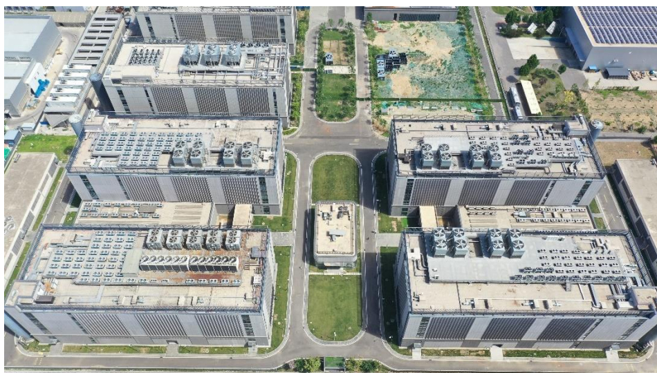
◇ 房山数据中心屋顶冷却塔
