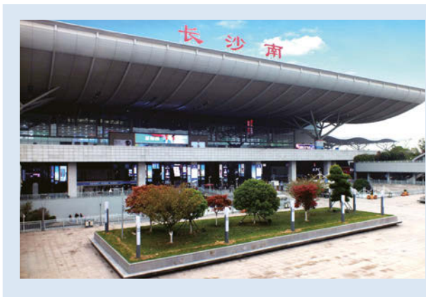
长沙南站综合能源服务项目
