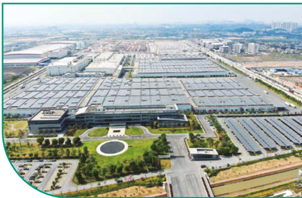
广汽智联新能源汽车产业园综合能源项目
