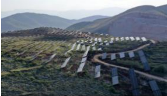
捐资 20 万元帮扶会泽鲁基村发展光伏发电产业
