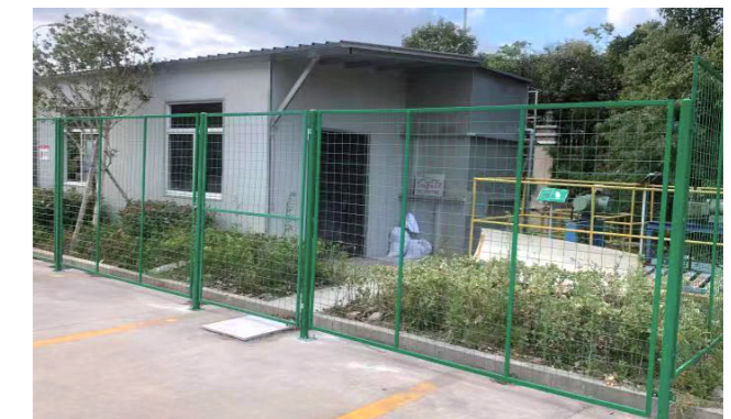
南洋公司污水处理站
