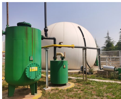
沼气囊与沼气热水锅炉
