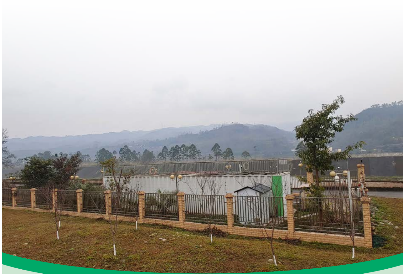
沙湾区污水处理厂
