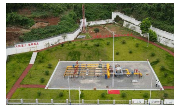
乐山市马铺调压站改建工程投运
