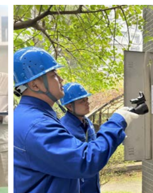
深入开展燃气安全隐患排查治理
