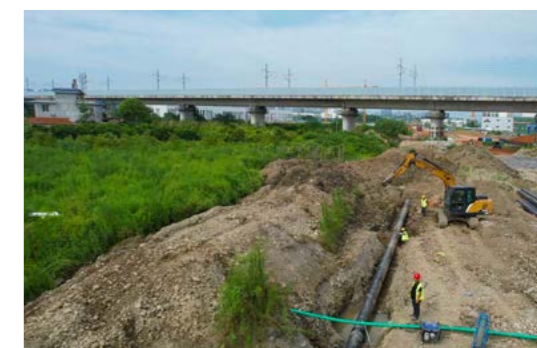
乐山高新区南新大道供水管道新建工程正式通水
