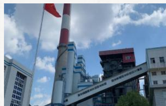
合肥热电锅炉烟气CCFB脱硫脱硝除尘超净排放
